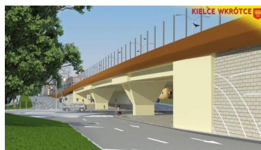
Wiadukt ul. Grunwaldzka
